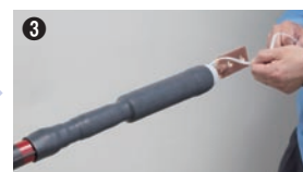
3 電界緩和部材をケーブルに通 した後に端子を取付け、電界 緩和部材を収縮させる。
