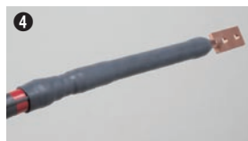
4 電界緩和部材の装着完成。
