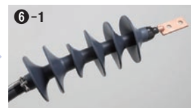
3 電界緩和部材をケーブルに通 した後に端子を取付け、電界 緩和部材を収縮させる。
