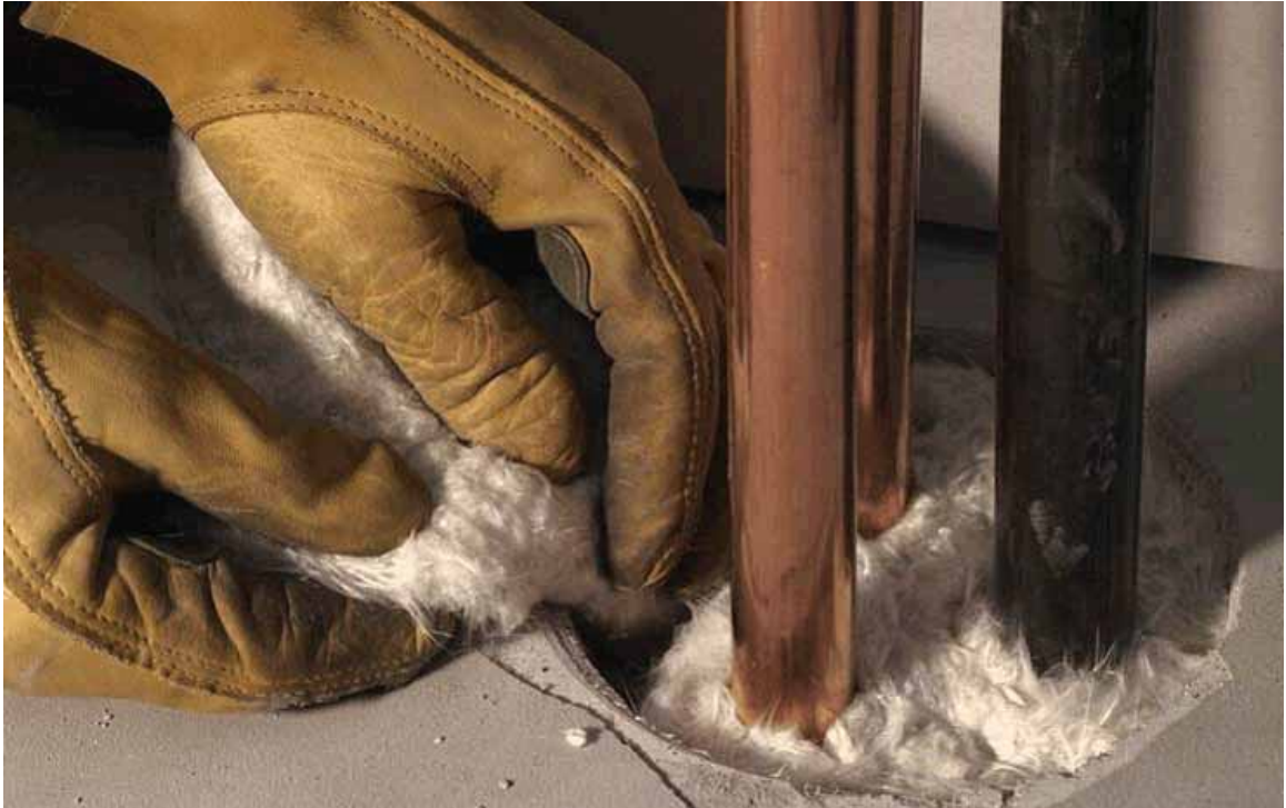
< 3 M > ファイヤーバリアー延焼防止用パッキング材 P M 4 施工の様子
